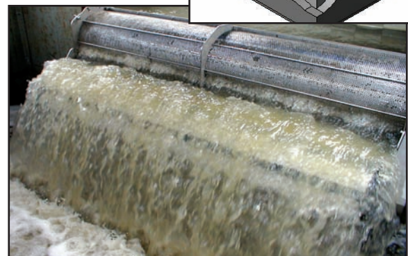
2 Stormscreens instalados para filtrar aguas pluviales
