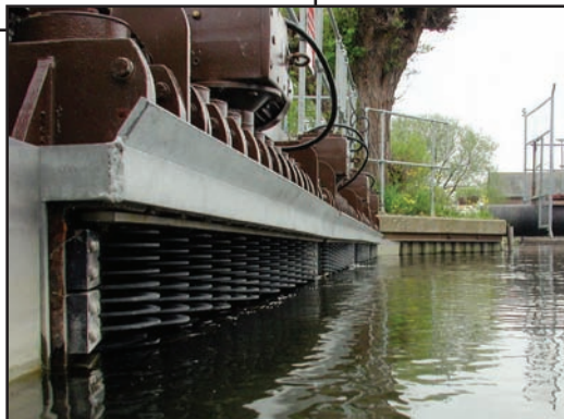
2 Stormscreens instalados para filtrar aguas pluviales
