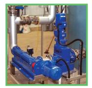
Bomba de transferencia y Muncher para desperdicios biodegradables
