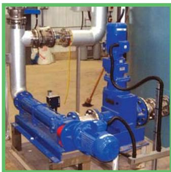
Bomba de transferencia y Muncher para desperdicios biodegradables
